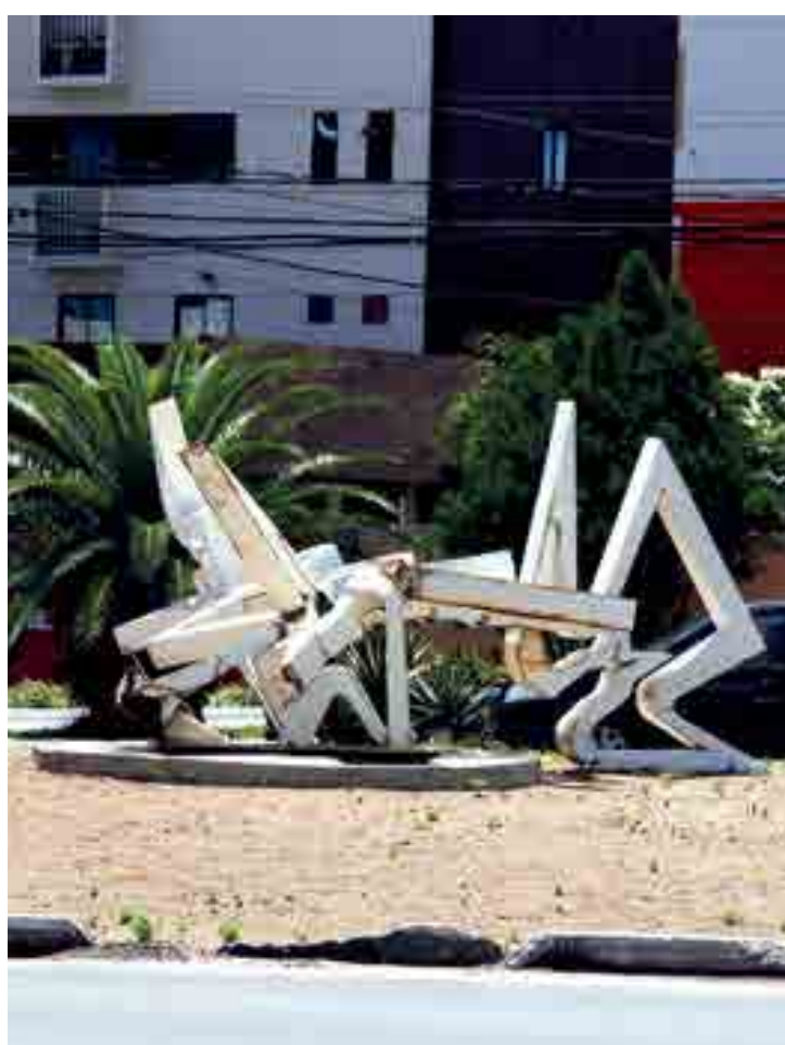
Tomado por ferrugem, monumento Revoar, da rotatória do Bessa, desabou
